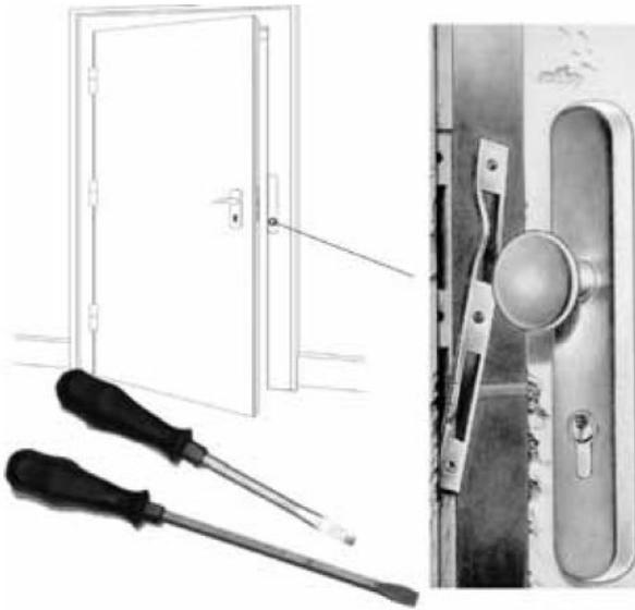
**Bild 6-3:** Schwachpunkt Schließblech
