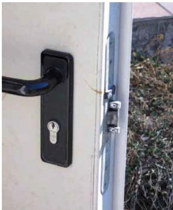
**Bild 6-8:** Notausgangsschloss, schwache Ausführung
