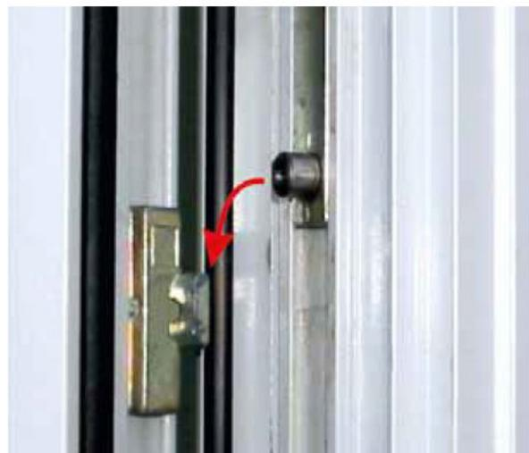
Bild 8-3: Rollzapfenbeschlag
