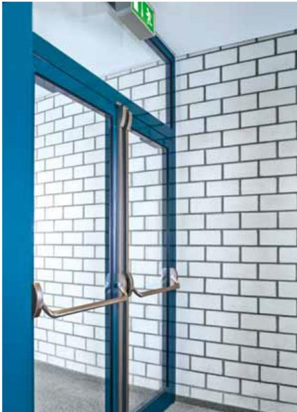
**Bild 6-11:** Druckbügel eines Panikverschlusses
